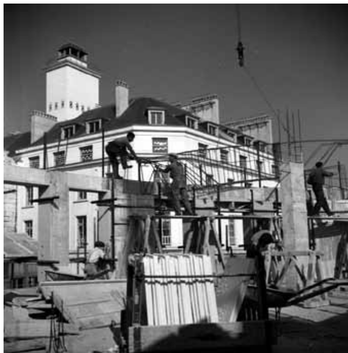
Illustration 3 : Chantier îlot n°7, Orléans, novembre 1949. Photographie : Henri Salesse. © MEDDTL - fonds MRU.
