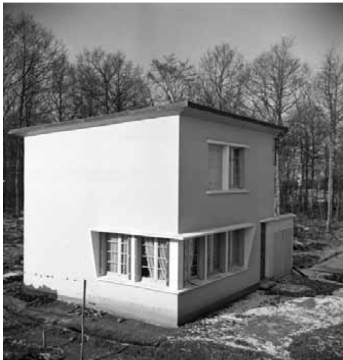
Illustration 4 : Chantier d'expérience, La Loupe (Eure et Loir), février 1952. Photographie : Henri Salesse. © MEDDTL - fonds MRU
